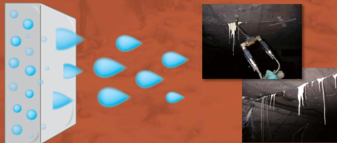
ポリイソシアネート化合物を主成分とした薬液による止水剤です。水に良く分散し反応します。反応した樹脂は急速に含水し体積膨潤してゴム弾性ゲルを形成します。また、発泡や界面活性作用(体積膨潤)により、地盤などのクラック、空隙に良く浸透し土粒子等と強固に接着するため優れた止水・シール・安定化効果が得られます。
