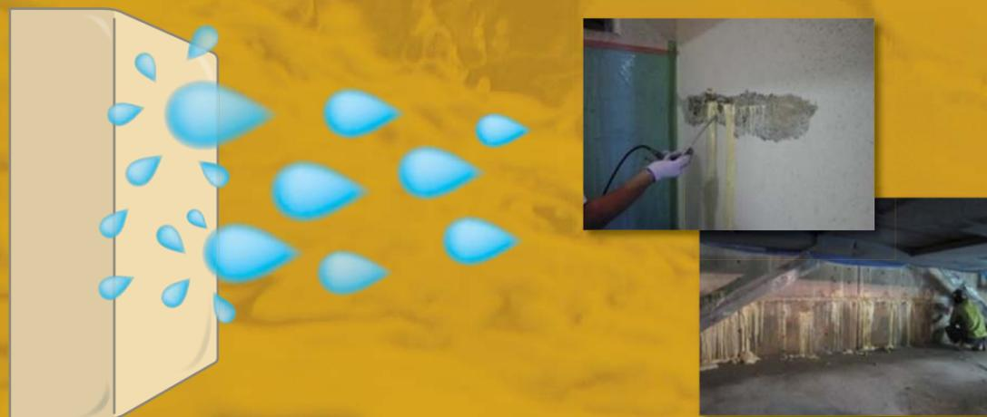
ポリイソシアネート化合物を主成分とした薬液による止水剤です。注入された触媒と混合された薬液は、水と反応することで炭酸ガスを発生し微細な空隙にも浸透し高強度で止水性の高い固結体、止水層を形成します。また、硬化物は化学的に安定しており、疎水性を保持しているため、水に溶け出さず土壌汚染等の影響を及ぼすことがありません。
